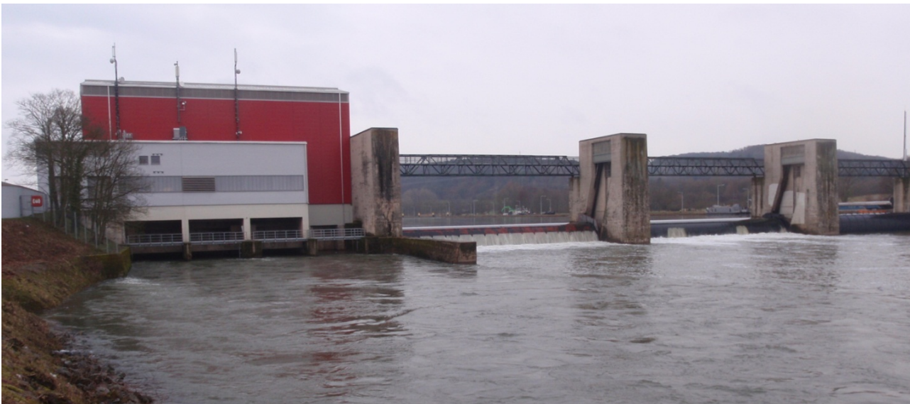
Bild 1: Staustufe Wallstadt mit künftigem FAA-Standort (linkes Ufer), Wasserkraftanlage (links), Wehranlage (rechts) und Schleuse (rechts außerhalb des Bildes), Blick von Unterwasser (Quelle: Heimerl)
