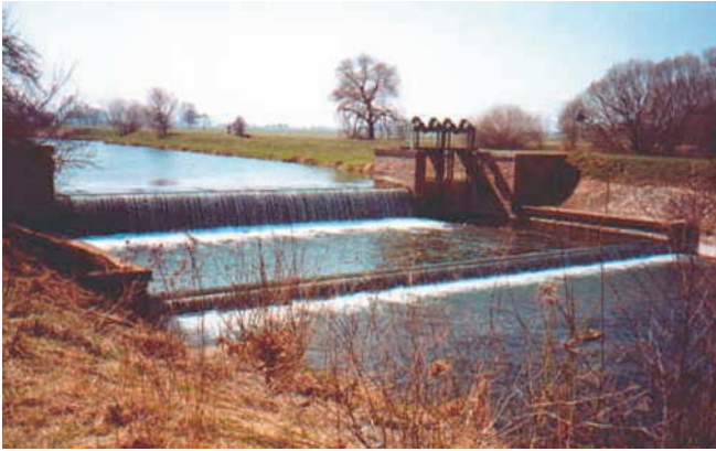
Abb. 2: Wehranlage „Hornissenberg“ an der Helme
