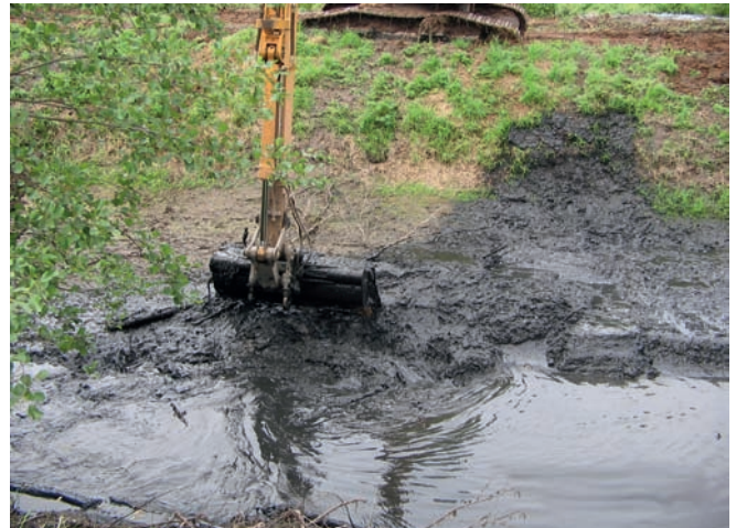
Abb. 8: Aushub der Schlammsedimente
