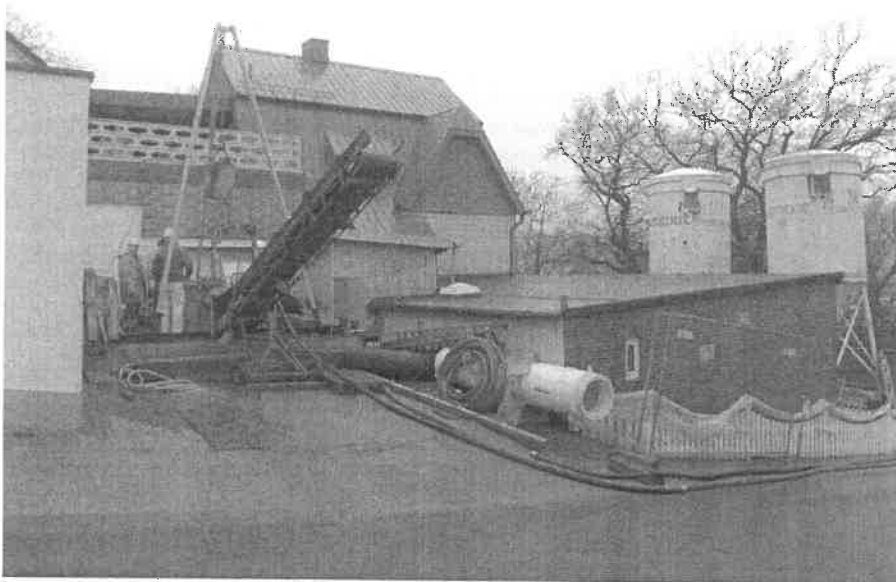
Abb.12 : Teufgerüst zur Aufwältigung des Tagesbruchs am "Alter Schacht"
