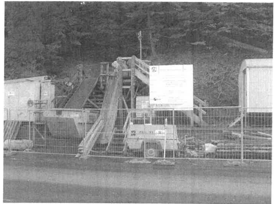
Abb.6 : Baustelleneinrichtung am Stollenmundloch
