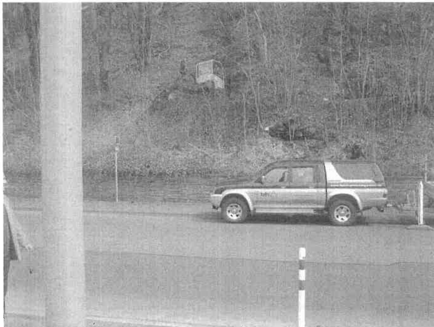
Abb.5 : Hangbereich an der Eiserfelder Str. und Schurf mit Stollenmundloch
