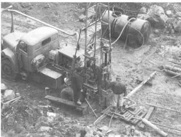
Abb. 2: Bohrgerät BA-500 am Bohrloch B 57. [Quelle: [1]]
