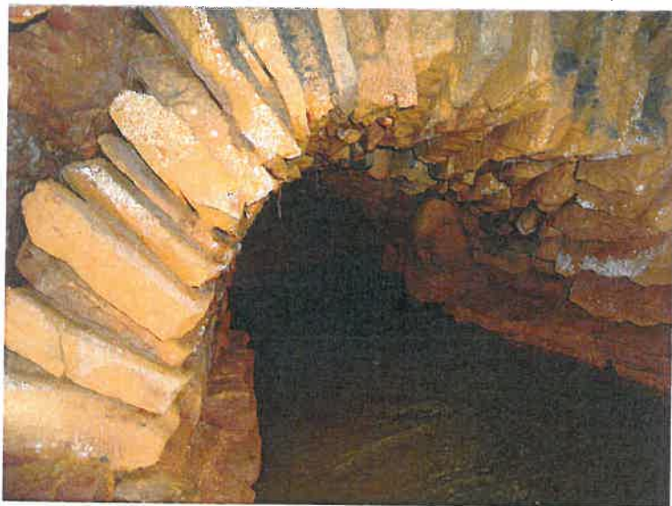
Abb.9 : Gewölbemauerung im Übergangsbereich zum Fels/Lockergestein
