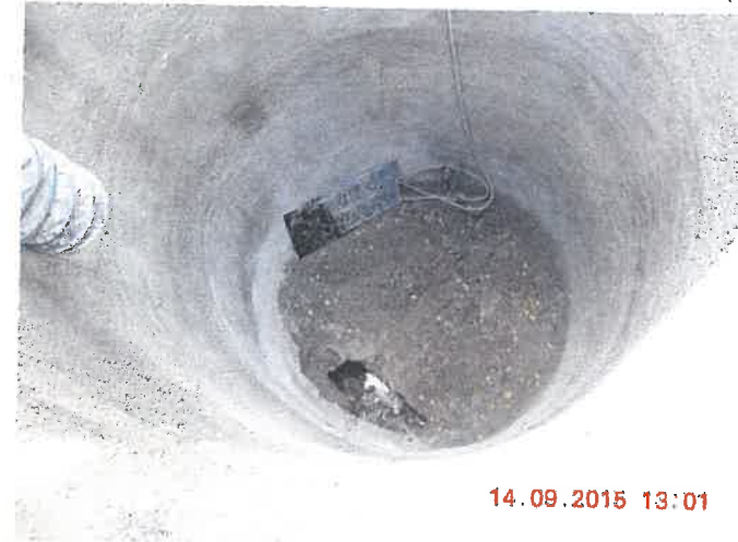
Abb.5 : Spritzbetonschacht mit Anschnitt des Querstollens
