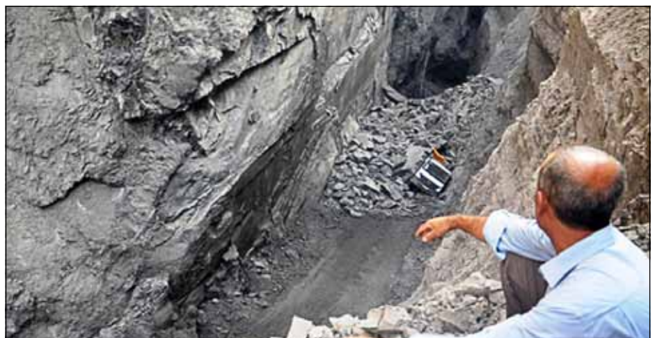
Bild 12: Felssturz im September 2013
