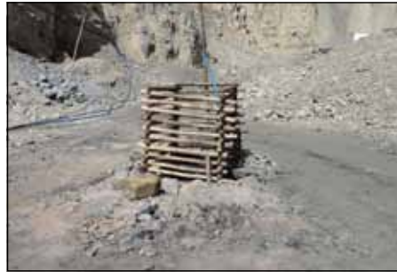
Bild 7: Beispiel eines Wetterschachtes
