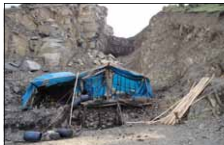
Bild 10: Schacht, Felssturzmassen im Hintergrund
