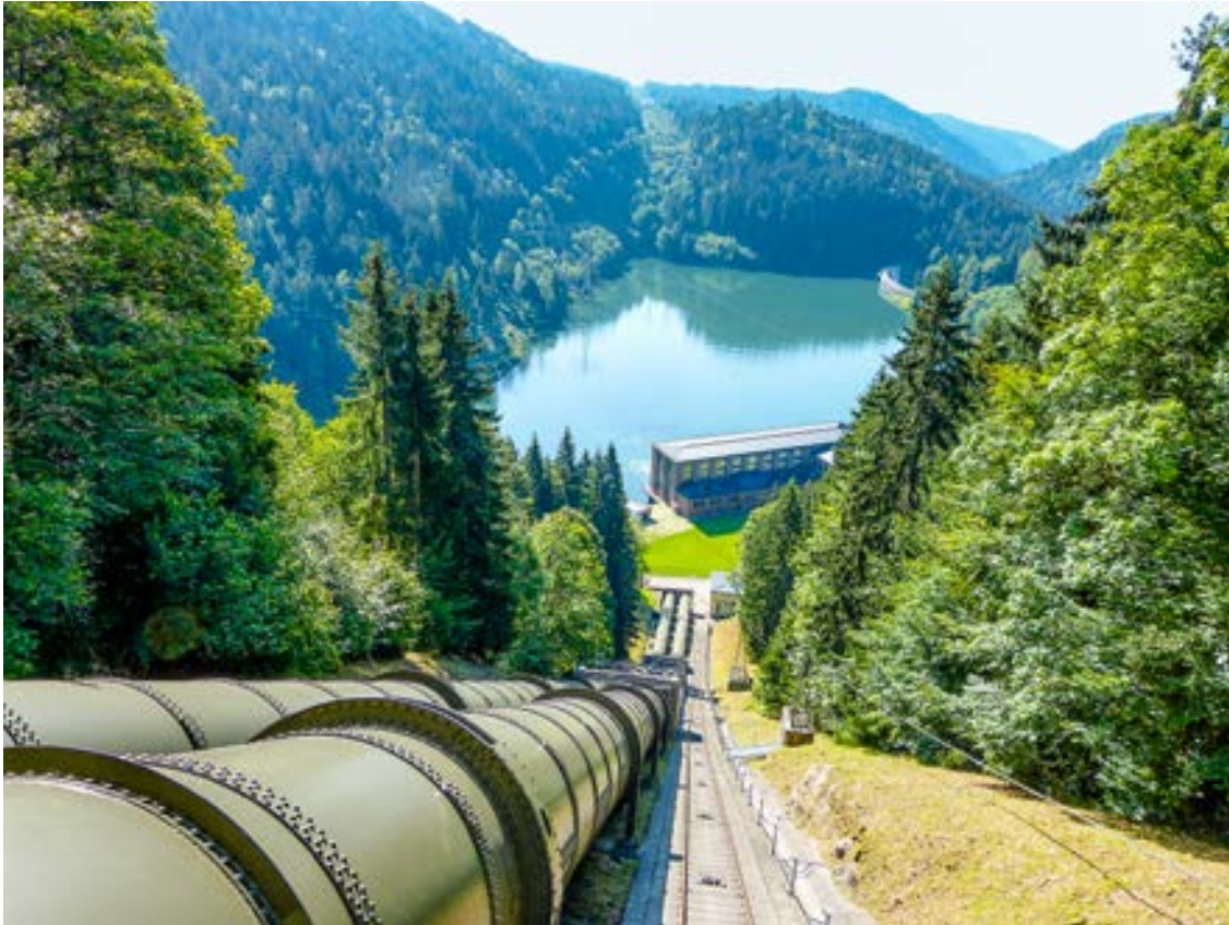
Pumpspeicherkraftwerk Häusern der Schluchseewerk AG mit Druckleitung und Schwarzabecken © Schluchseewerk AG
