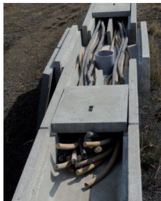
Möglichkeiten für den Zugang zur Halbschale: Umlenkstelle (links) mit einer Aufsatzöffnung und größerer Kabelkanal mit einem Aufsatzrohr in der Mitte (rechts).
