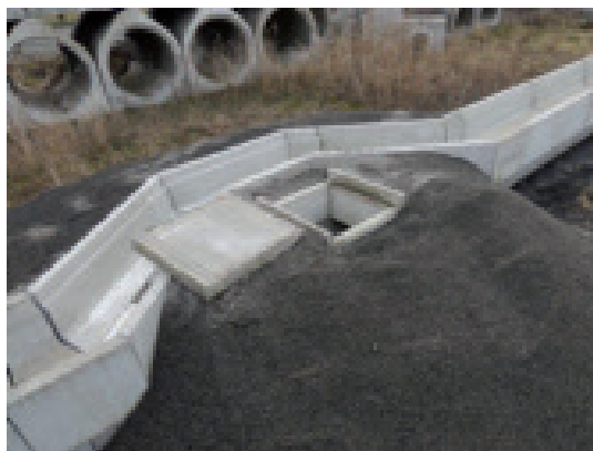
Möglichkeiten für den Zugang zur Halbschale: Umlenkstelle (links) mit einer Aufsatzöffnung und größerer Kabelkanal mit einem Aufsatzrohr in der Mitte (rechts).
