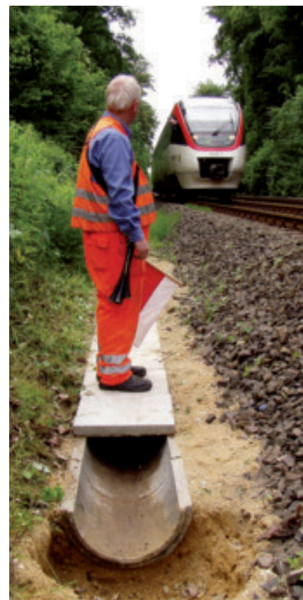
Konzept des Drän-Versickerungssystems: Oben mit aufgesetztem Kabelkanal und unten in der »Standard-Ausführung«. Fotos: Porosit
