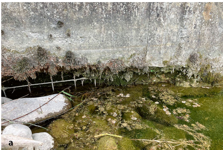
Bild 3: Beispiele für die Gesamteinschätzungen von Bauwerken: a) Freiliegende Bewehrung in der Wasserwechselzone; b) Schalenablösung und Bewuchs auf einem festen Wehrkörper
