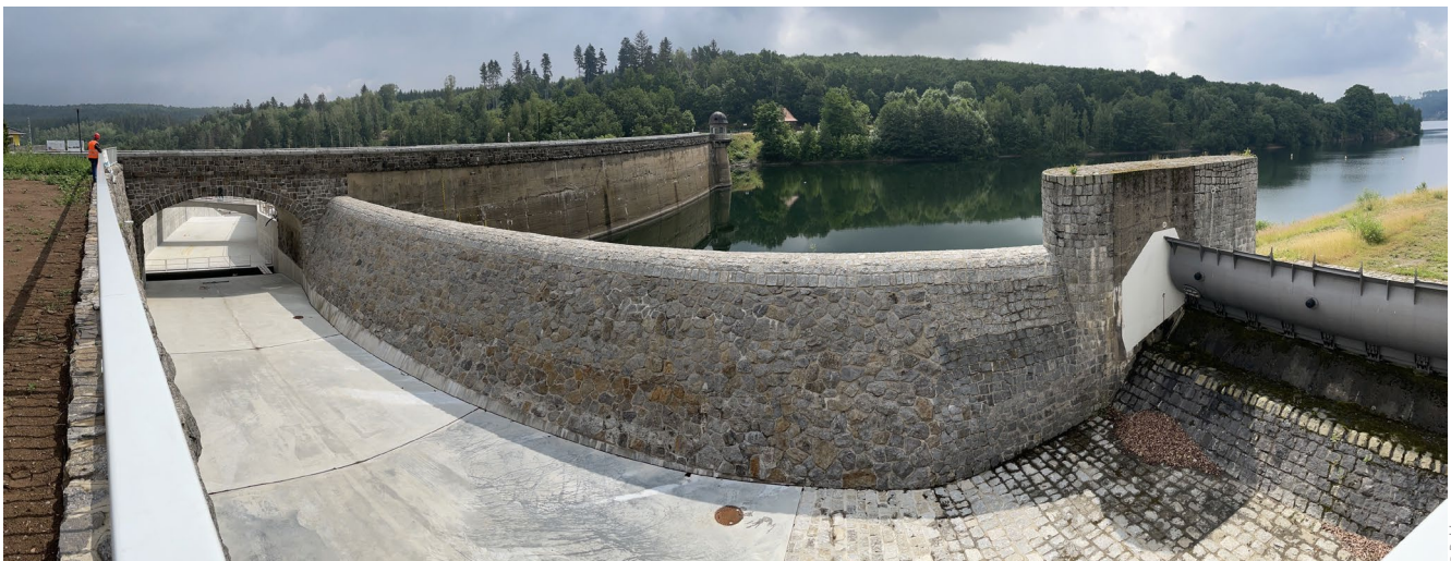
Bild 2: Erweiterte Hochwasserentlastung der Talsperre Malter
