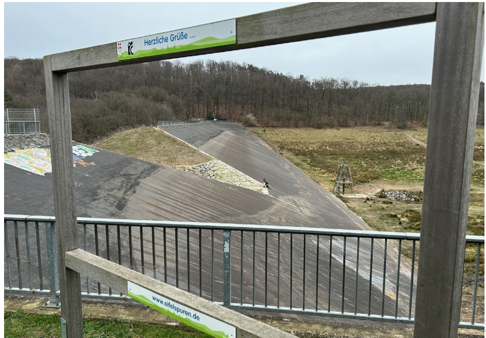
Bild 1: Steinbachtalsperre (NRW) mit der Schlitzung zur Gefahrlösstellung
