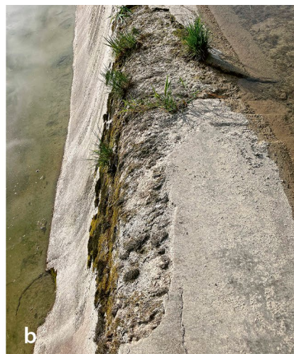
Bild 3: Beispiele für die Gesamteinschätzungen von Bauwerken: a) Freiliegende Bewehrung in der Wasserwechselzone; b) Schalenablösung und Bewuchs auf einem festen Wehrkörper
